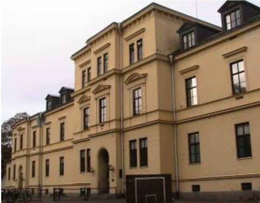
Sjukhusbyggnaden på Strömbacken används numera som en del av Ebersteinska gymnasiet.
