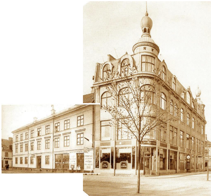
Hörnet Östra Boulevarden–Cardellsgatan (collage). ”Storehus” till vänster.
